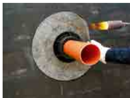
5. Încălzirea izolației din bitumen cu flacăra
